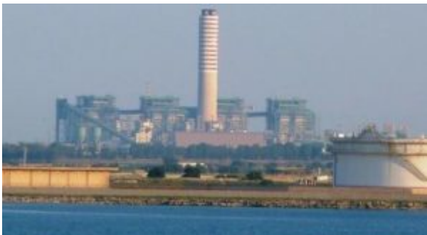
Brindisi – Centrale di Cerano
